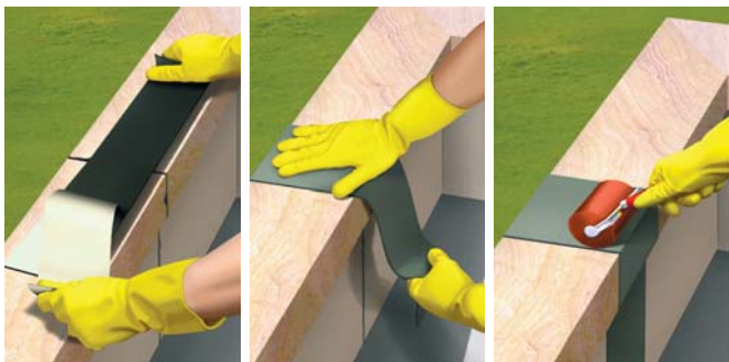
Снять изолирующую бумажную ленту
